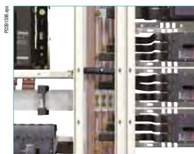
Через комплекты для подсоединения заводского изготовления осуществляется питание аппаратов, установленных справа и слева от силовых шин
